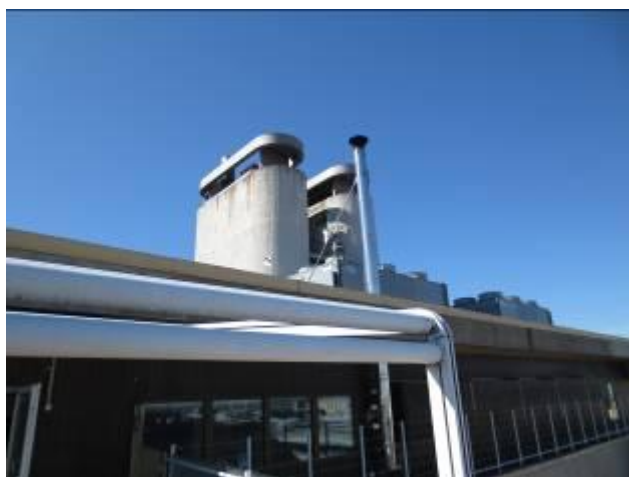
Helsingin Eteläranta 10:n poistoilmakatokset tervehtivät Eteläsatamaan tulijoita vielä jonkin aikaa merellisellä laivan piippua muistuttavalla muotoilulla. (BHa)
