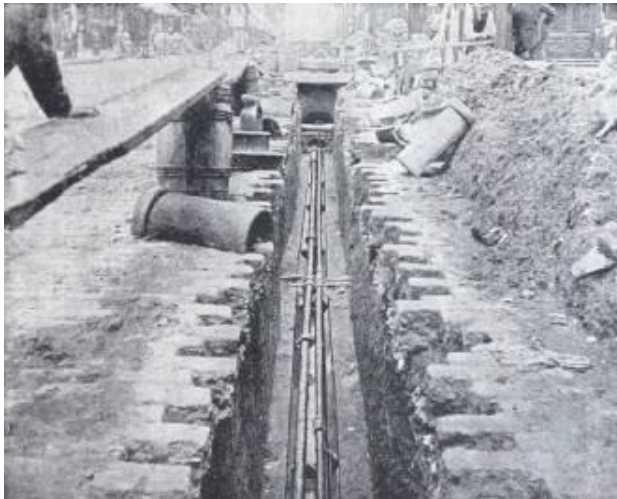
Kaukojäähdytysputkien asennusta New Yorkissa 1891. (Am)
