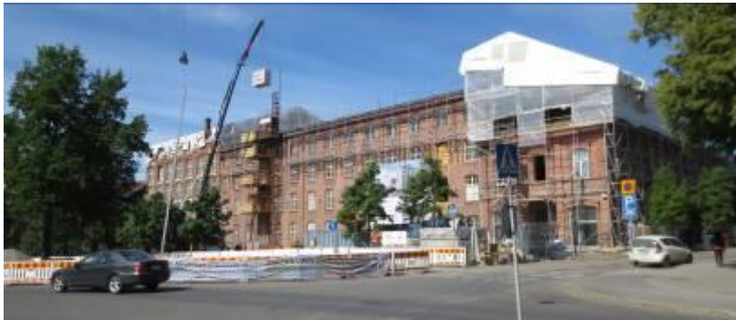
Pellavatehdasta, sittemmin toimistorakennusta, muutetaan sairaalaksi Tampereella 2016. (BHa).
