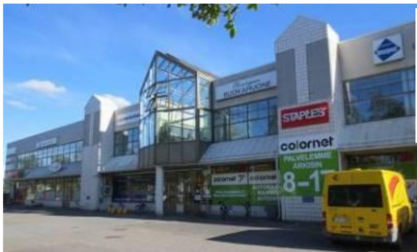
Ilmanvaihtokuiluista on kehitetty näyttävää ilmeikkyyttä 1989 valmistuneeseen toimitaloon Tampereella. (AX:n toimitalo 2015, BHa)
