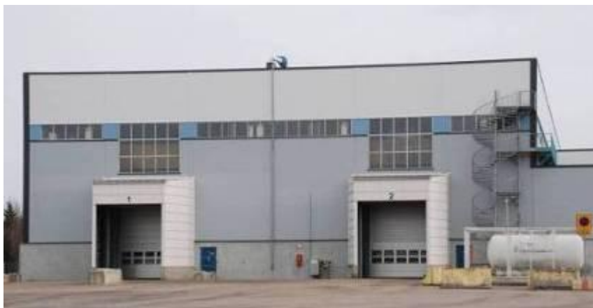
Tunneliportteja entisen Valmetin putkitalotehtaan ja nykyisen kattilavalmistuosaston ovissa. (BHa)
