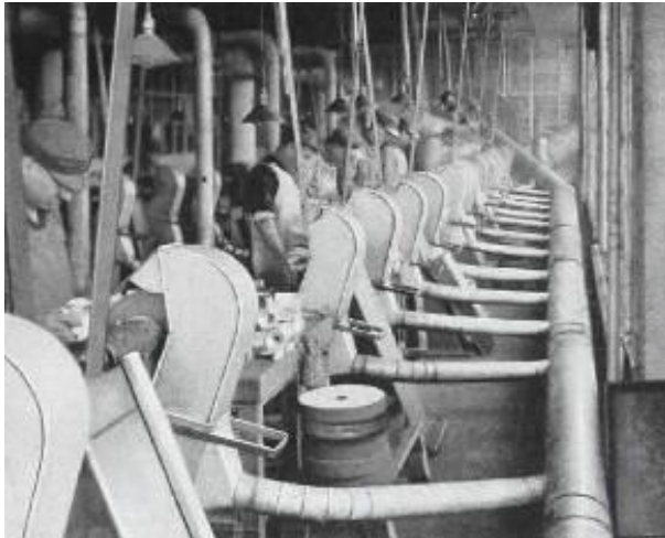
Myös konepajoissa ovat kohdepoistot olleet tärkeitä, kuvassa hiomon pölynpoistolaitteisto 1920. (Am)
