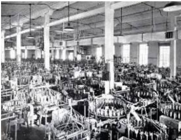
Erytisesti kehräämöissä hyvä kostutettu sisäilma on oleellista estämään pölyämistä ja kuitujen katkeamista. Kuva vuodelta 1920. (Am)
