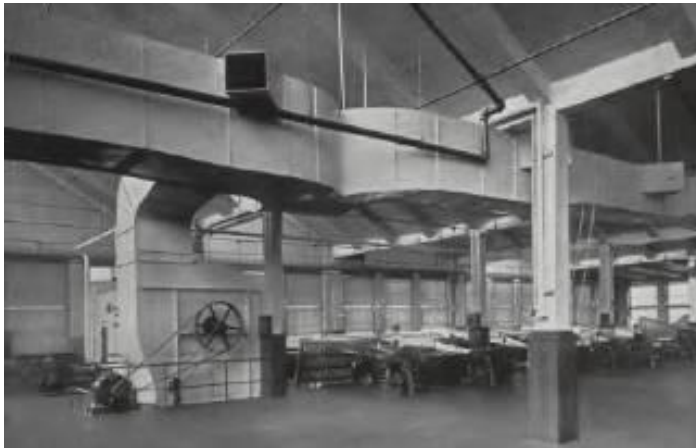
Teollisuuden ilmastovaihtolaitteet ovat olleet aika järeitä, mutta ratkaisut simppeleitä. Pääasia ilmajossakin vuodelta 1915 näyttää olleen, että ilma lentää pitkälle. (Am)
