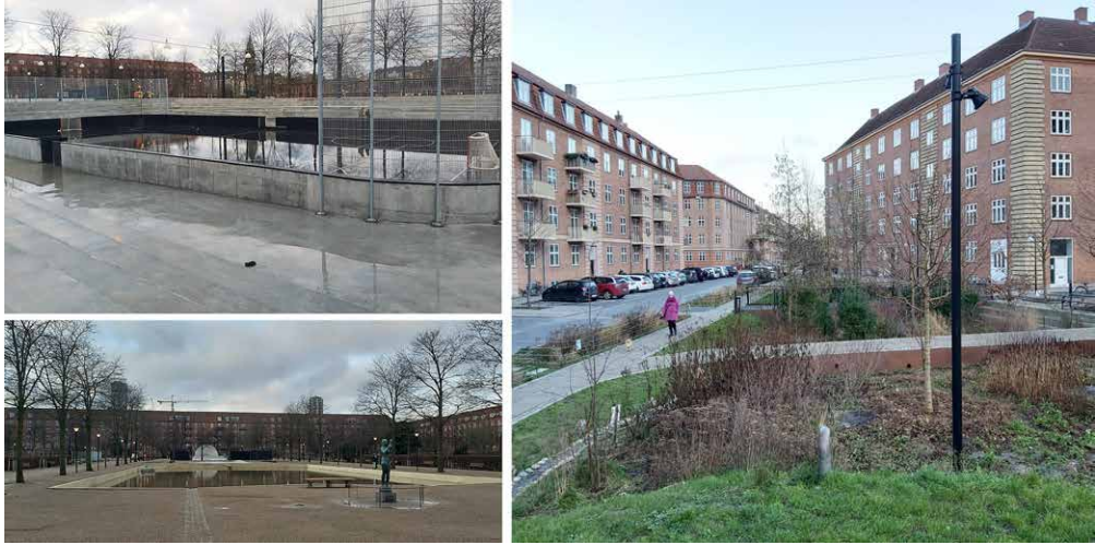
Kuva 7. Kuvat vasemmalla: Enghave-puistossa, Kööpenhaminassa (valmistunut syksyllä 2019), urheilukenttää on laskettu 3 metrin syvyydelle mahdollistaen tulvavesien varastoimisen. Puiston vanha allasta on myös muokattu niin, että vesiä voi ohjata altaaseen rankkasateella. Yhteensä puistossa voi varastoida 24 000 m 3 . Kuva oikealla: Täsinge plads on Kööpenhaminan ensimmäisiä tulvarakenteita (valmistunut 2014) ja on saanut paljon huomiota myös kansainvälisesti. Puistossa voi varastoida noin 7 000 m 3 .
