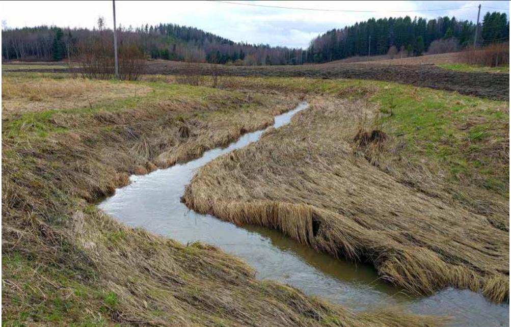
Kuva 1. Tulvatasanteellinen kaksitasouoma Sipoon Ritobäckenillä. Alivesiuoman oikealla puolella on reilut kahdeksan vuotta sitten rakennettu tulvatasanne, joka on alentanut ylivirtaama-aikaisia vedenkorkeuksia ja parantanut veden laatua. Keväällä otettu kuva näyttää, että uoma on toiminut toivotulla tavalla. Taipunut ruohokasvillisuus osoittaa, että lumensulantavedet ovat virranneet tulvatasanteella, mutta pellon reunassa ei näy tulvan jälkiä.
