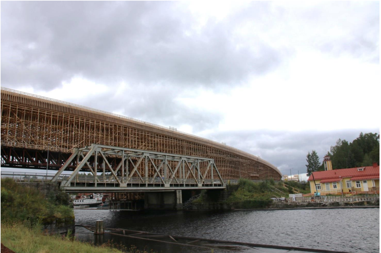
Kuva 8: Laitaatsalmen sillan telinerakenteet hallitsevat maisemaa Savonlinnan länsipuolella
