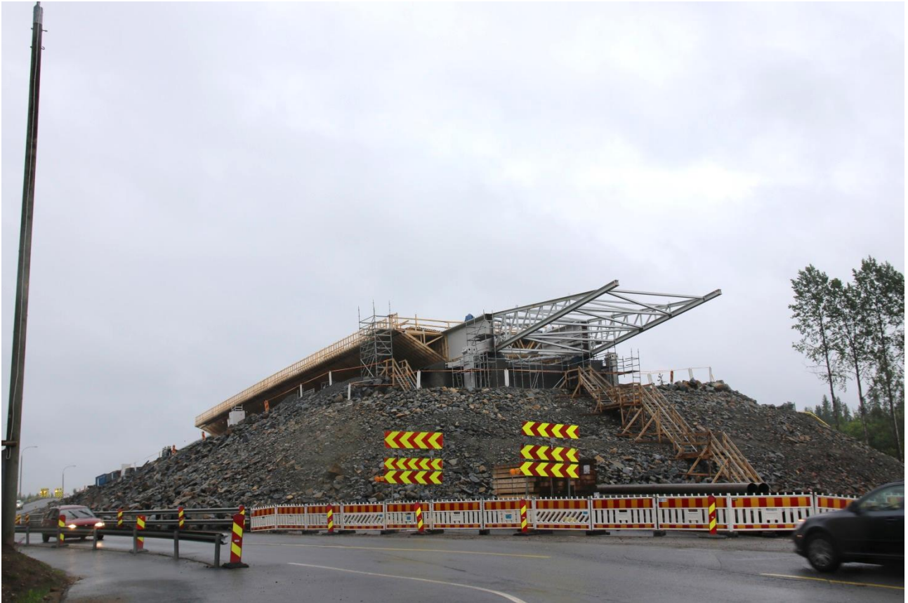
Kuva 7: Itäisien lohkojen työntöasennus oli alkuvaiheessa
