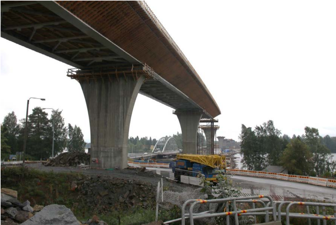
Kuva 3: Siltaa lännestä itään
