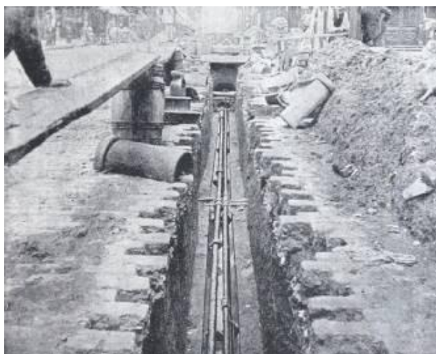
Kaukojäähdytysputkien asennusta New Yorkissa 1891. (Am)
