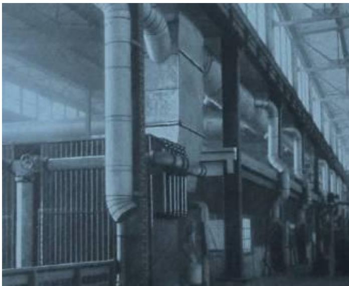
Kuvassa vuodelta 1920 on oikeaoppista lämmitetyn ilman jako eli puhallus alas. Isojakin koneita sijoitettiin tuotantotilaan, kun äänitaso osastoilla oli muutoinkin korkea. (Am)
